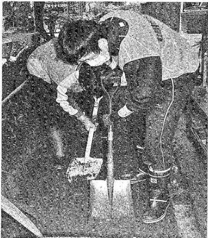
汚泥をスコップでかき出す作業
