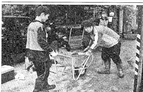
かき出した汚泥の運搬作業
